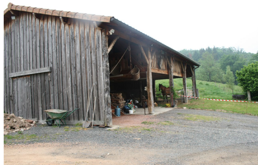
D. Le hangar existant
