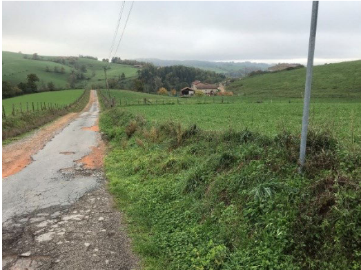
Chemin des Horts avant travaux
