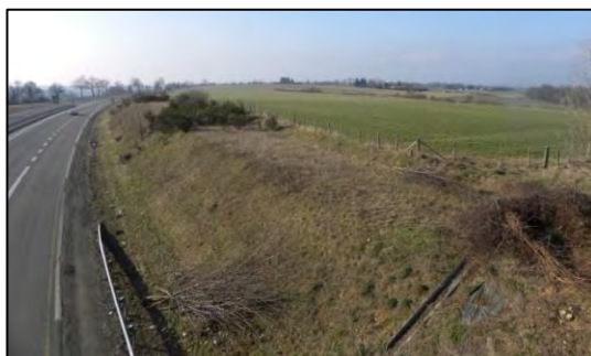
Vue depuis le pont sur la RN82
