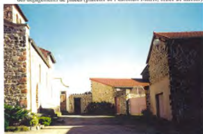
Le point fort de NEAUX se révèle être l'église et la placette où les éléments bâtis s'intègrent les uns aux autres (églises, murs, granges et butisse) et sont soulignés par la végétation (massifs discrets, hortensias).
