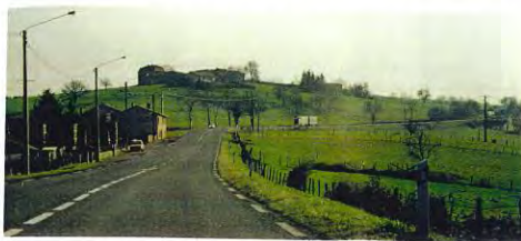
Encaissée vers le noeud de l'Hôpital-sur-Rhins, la R.N. 7 s'élève sur le versant de la vallée du Gand pour bénéficier d'une situation de balcon sur les Montagnes du Matin.
