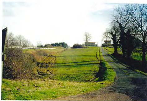
L'ancienne R.N. 7 emprunte un tracé sinueux en balcon sur le versant de la vallée de l'Ecoron (au Nord), tandis que la nouvelle R.N. 7 se réapproprie presque le tracé de la route Napoléon (à droite sur la photo).
